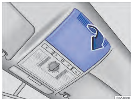
Fig. 157 No revestimento do teto: remover a cobertura.
